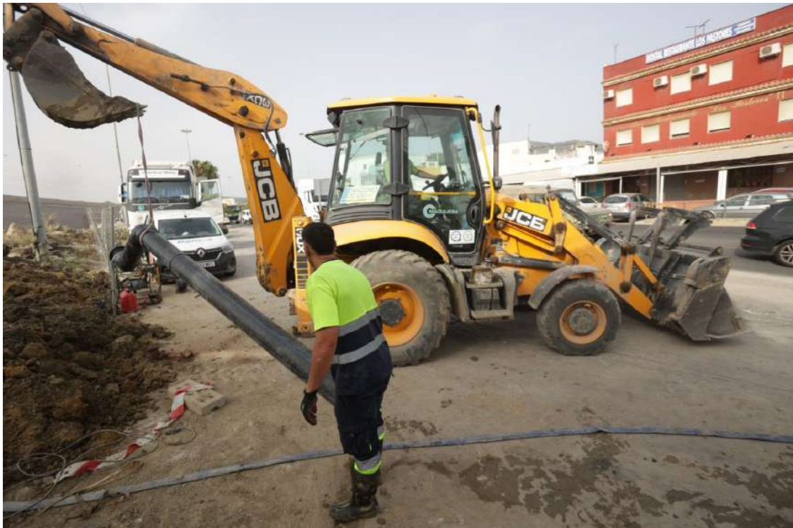
Los trabajos de conexión de la nueva conducción obligan este jueves a interrumpir el suministro de agua en Getares, La Aldea y la zona del Faro.
