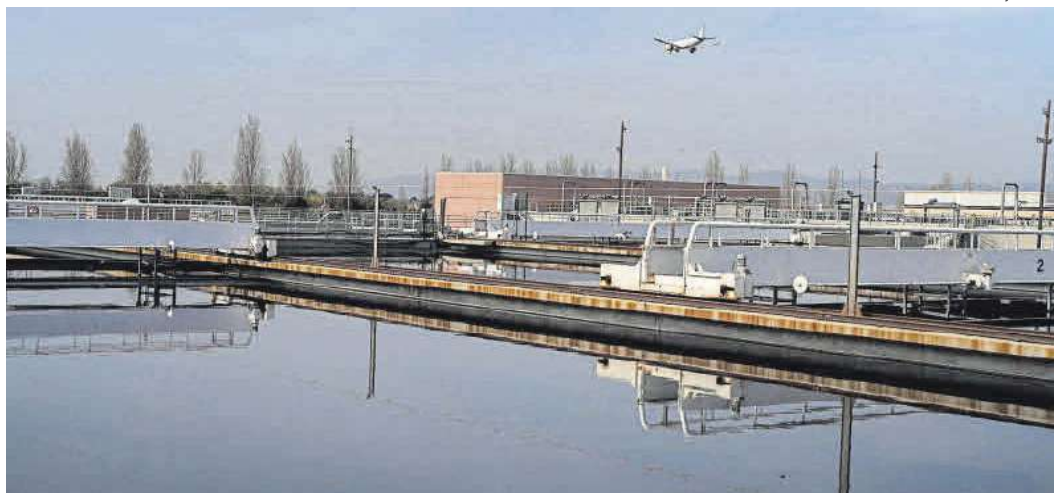
La depuradora del Prat de Llobregat.
