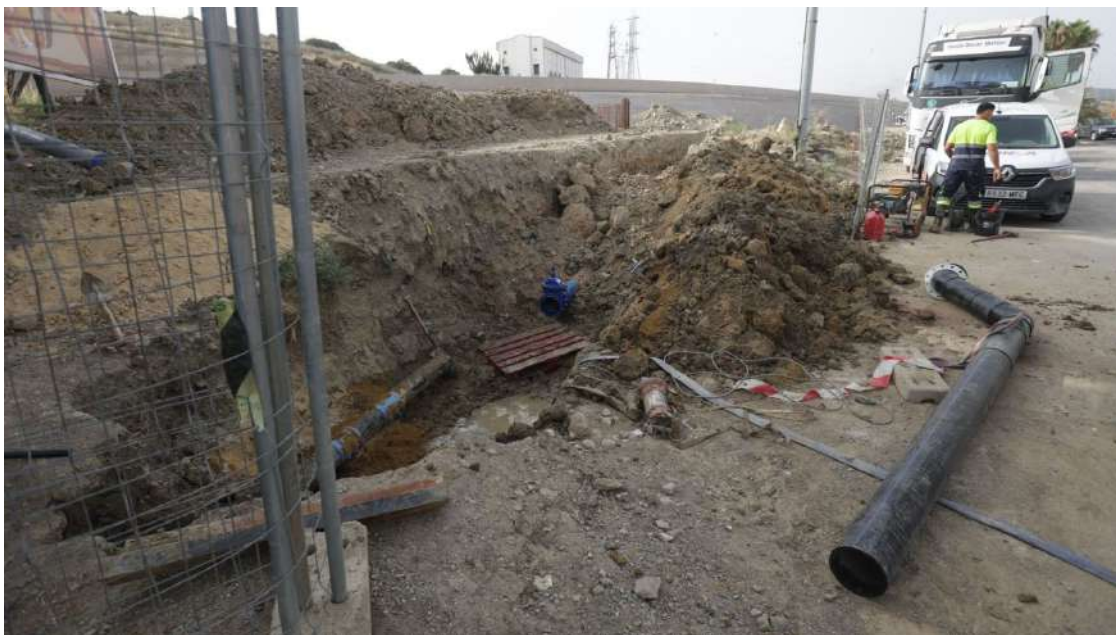
Operarios trabajan este jueves en la conexión de la nueva tubería de abastecimiento en la zona de Los Pastores, dentro de las obras del Acceso Sur de Algeciras.
