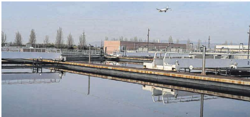
La depuradora del Prat de Llobregat.
