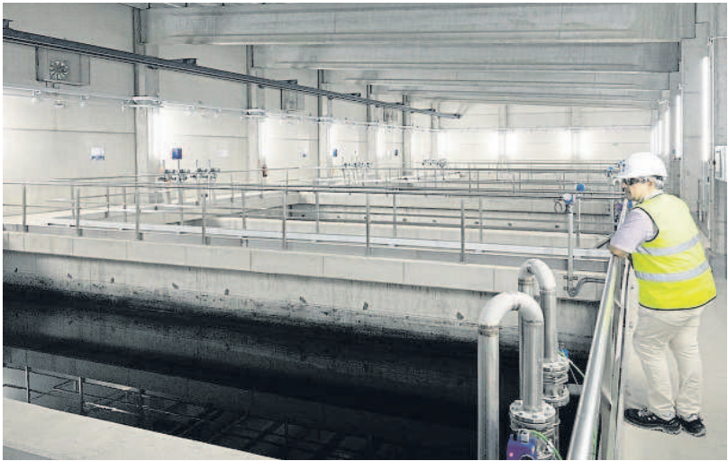
La planta potabilizadora de agua de Sant Feliu de Llobregat, que recientemente se remodeló
