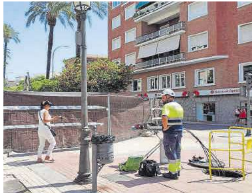
Obras en la avenida de Huelva.
